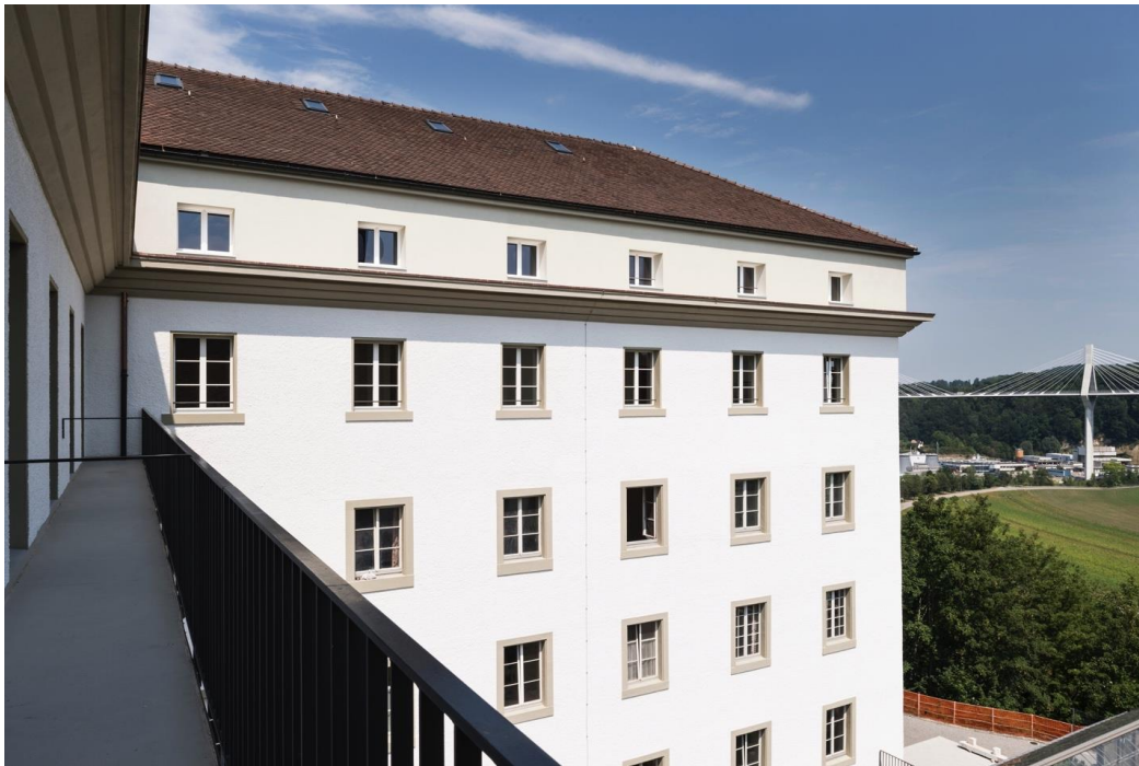
Vue du balcon d'un studio du 3 ème étage
